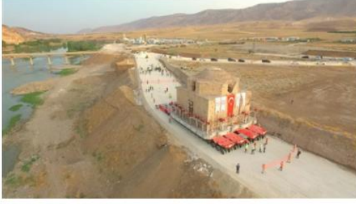
Şekil 1: Artuklu Hamamı'nın taşınmasına ait fotoğraf
